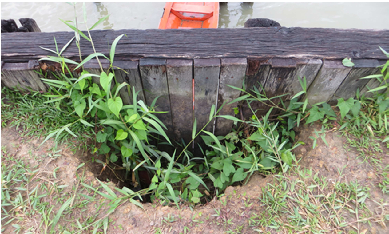
Figura 13: Erosão no aterro é caminho preferencial para o escoamento superficial.
