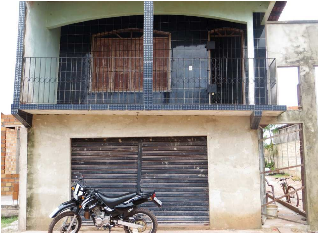
Figura 7: Ocorrência de recalque na residência.
