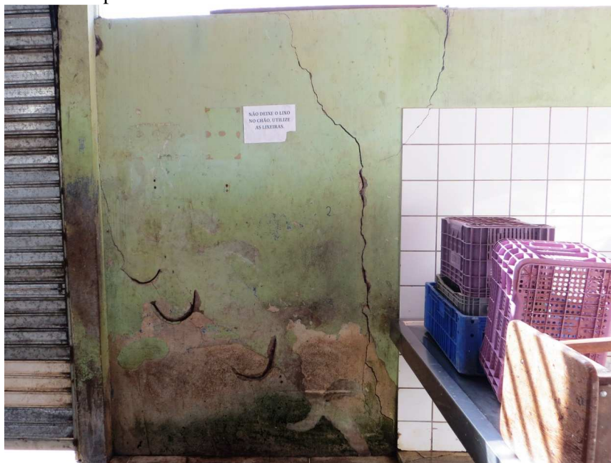
Figura 15: As trincas são paralelas a Av. Quinze de Agosto e apresentam aproximadamente 3 m de comprimento e 1 a 4 cm de espessura.
