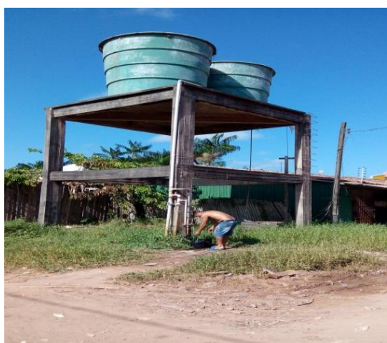
Figura 39: Ponto de abastecimento de água na Chicolândia-Algodoal
