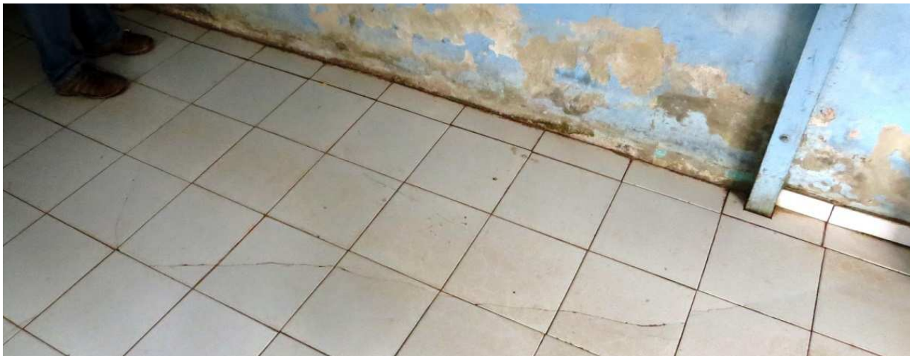
Figura 5: Ocorrência de trinca no piso da residência.
