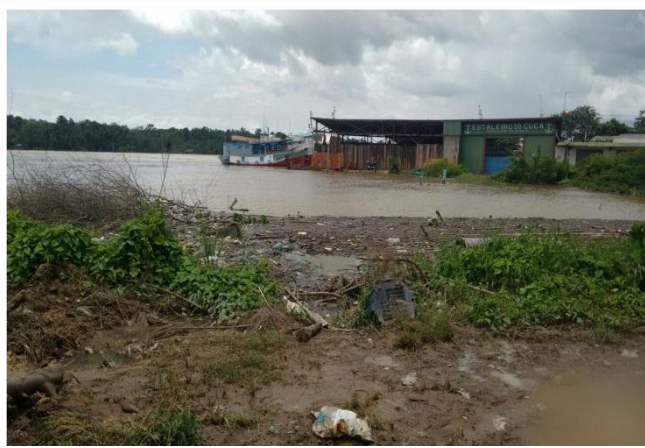
Figura 41: Estaleiro do Cuca na área do colapso.
