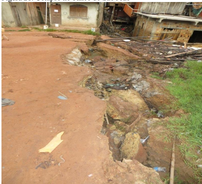
Figura 28: Colapso no bairro do São João
