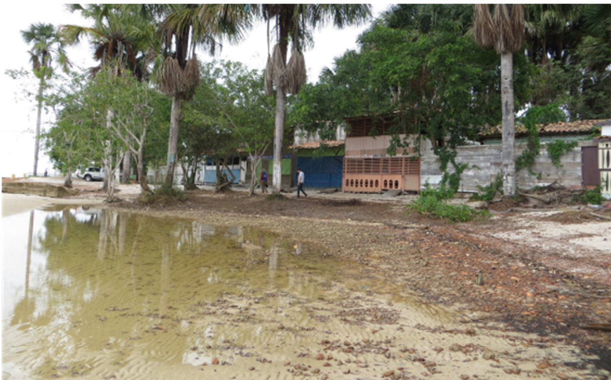
Figura 20: Notar que a linha de costa está a menos de 1m das residências.
