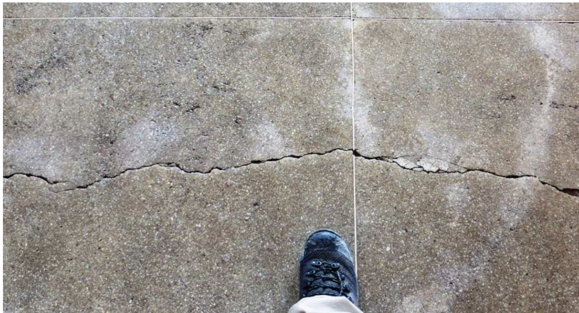
Figura 15: As trincas são paralelas a Av. Quinze de Agosto e apresentam aproximadamente 3 m de comprimento e 1 a 4 cm de espessura.
