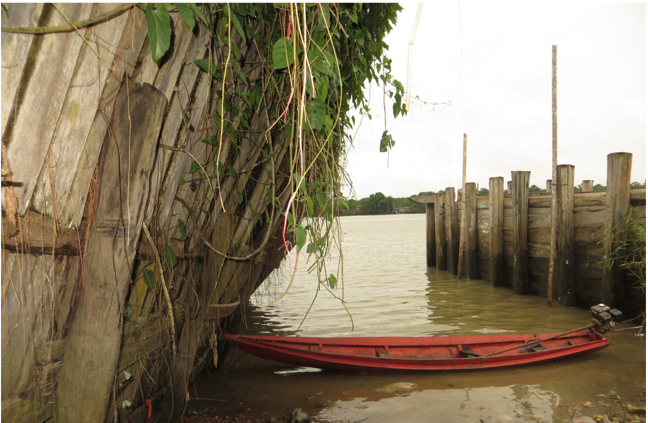
Figura 9: Obra de contenção de madeira em processo de tombamento.
